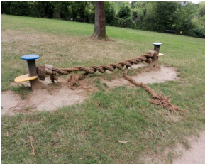
Balancierseil beschädigt
